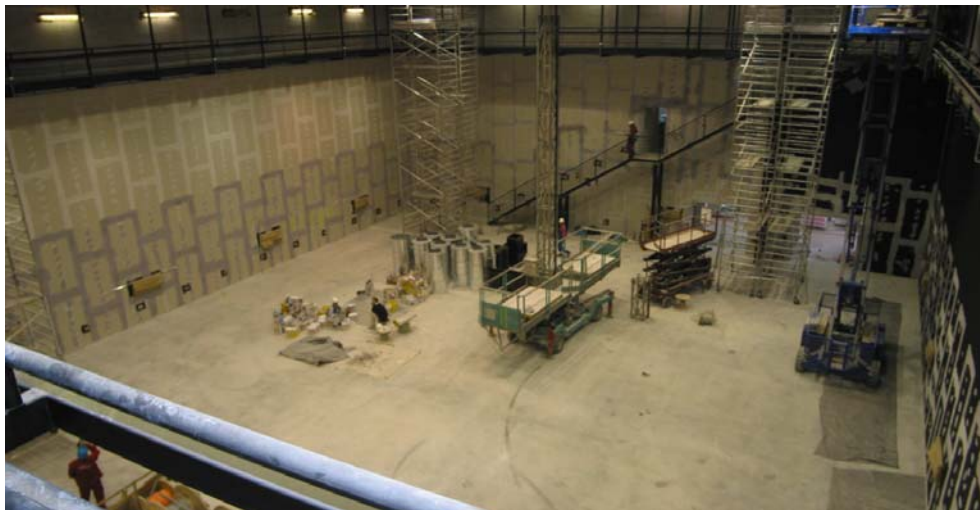
A 3-as stúdió hanggátló gipszkarton előtétfalainak szerelése után.
